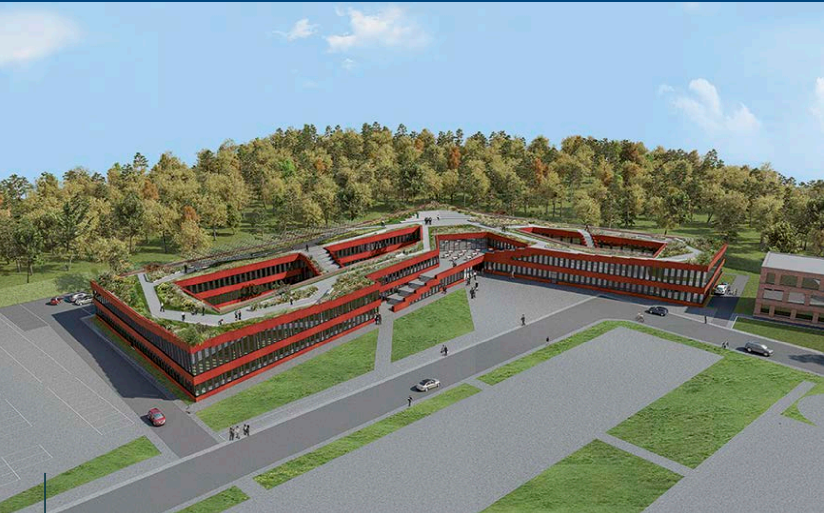
Der Neubau der RAG-Stiftung und RAG AG, der derzeit auf dem Areal der ehemaligen Kokerei Zollverein in Essen entsteht, beachtet das C2C-Prinzip.
