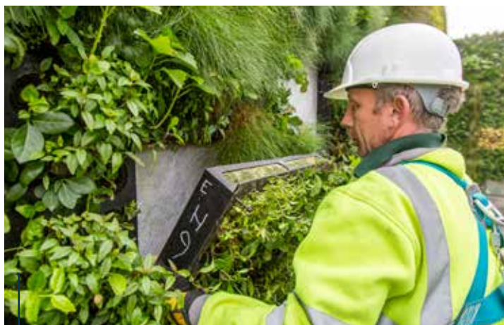
„Helix Biomura“ ist vergleichbar mit einer vorgehängten Fassade. An Aluminiumhalterungen werden die begrünten Kassetten befestigt.
